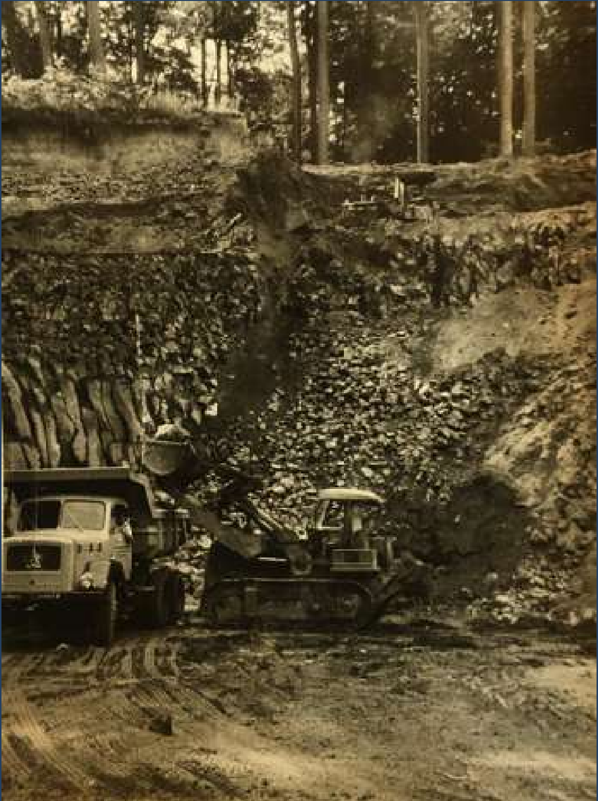
Beladung Muldenkipper mit Laderaupe an der Bruchkante
